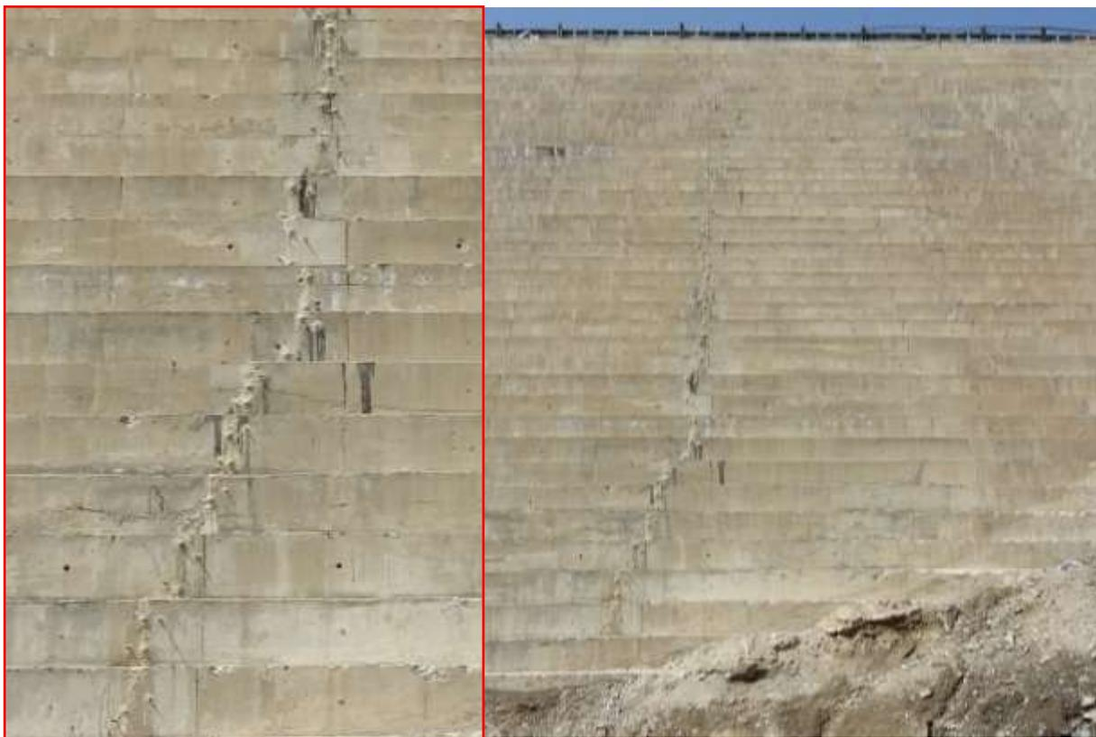
**Рисунок 2.** Фото тела плотины, показывающее размер трещины
