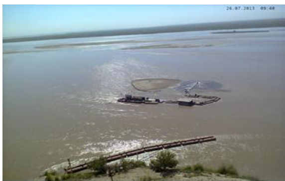
Рисунок 3. Регулирование русла реки с помощью земснарядов и подача воды на насосную станцию № 1 по главному русловому каналу
