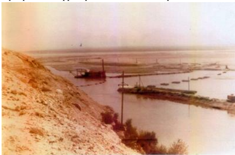
Рисунок 2. Общий вид русловой обстановки реки в районе бесплотинного водозабора Каршинского магистрального канала (дноуглубительные очистные работы в русле реки перед водозабором)
