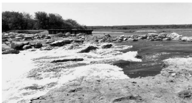
Рис. 2. Общий вид разрушения части грунтовой плотины при переливе воды
