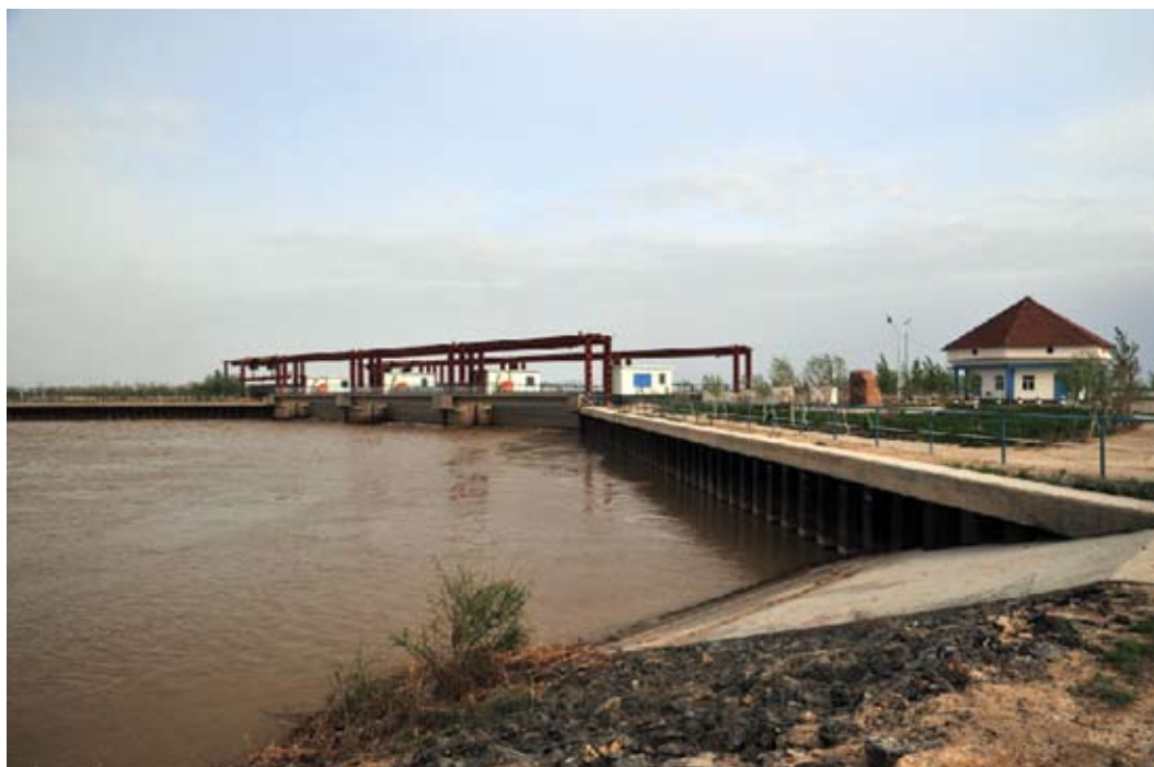
Рисунок 2. Айтекский гидроузел на реке Сырдарье
