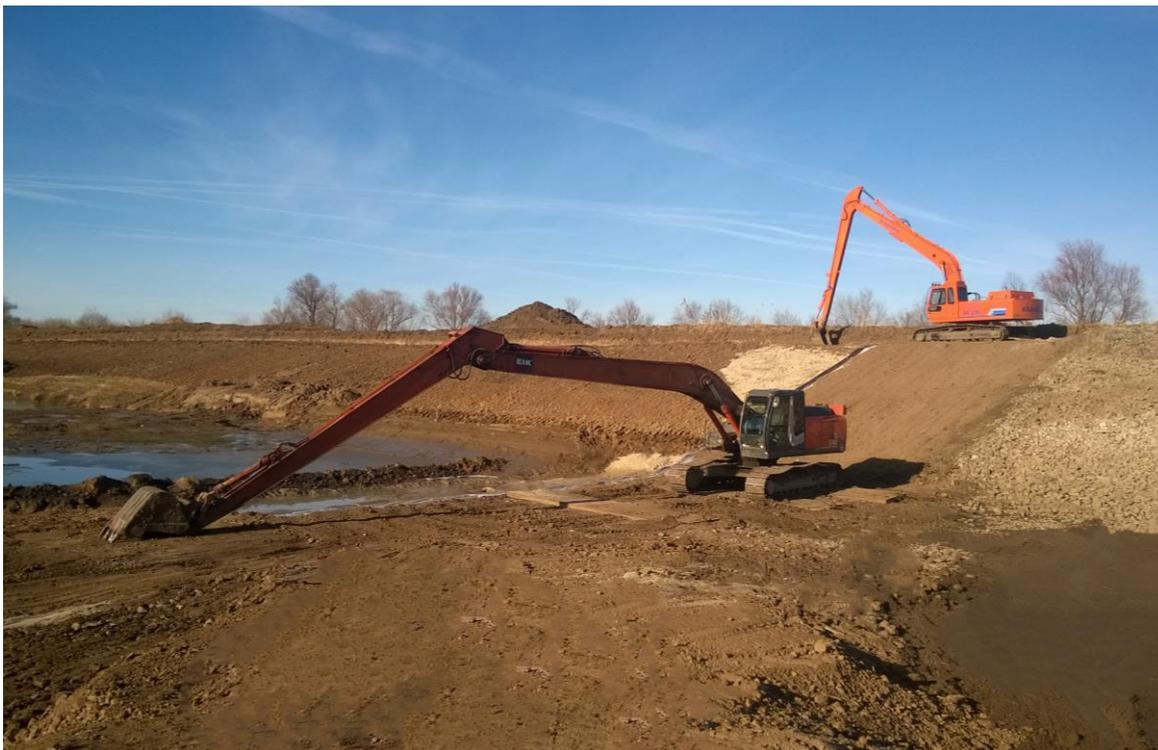
**Рисунок 2 – Технология устройства противофильтрационной облицовки на участке магистрального канала
