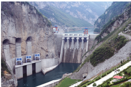
Рис. 2. Ступенчатый бетонный водосброс гидроузла “Со Фэн Ин” (снимок сделан в эксплуатационный период - в 2009 г.)
