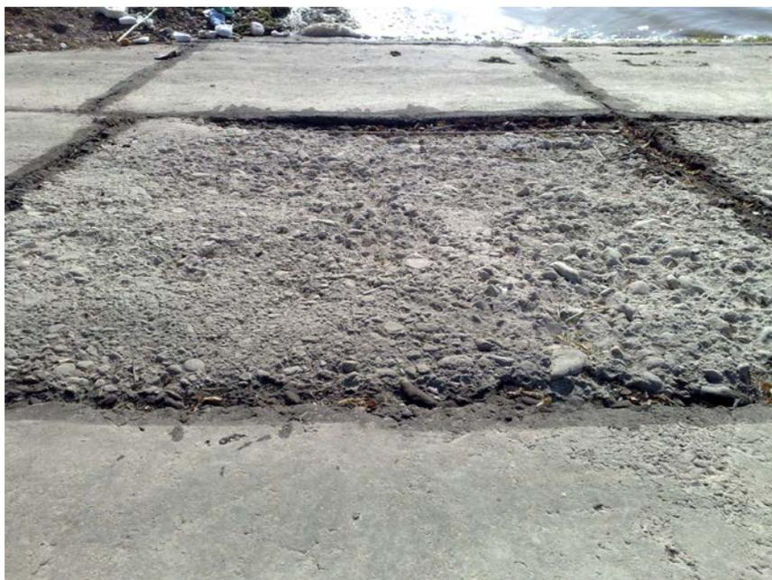
Рисунок 1 - Коррозия элемента покрытия Ташводохранилища
