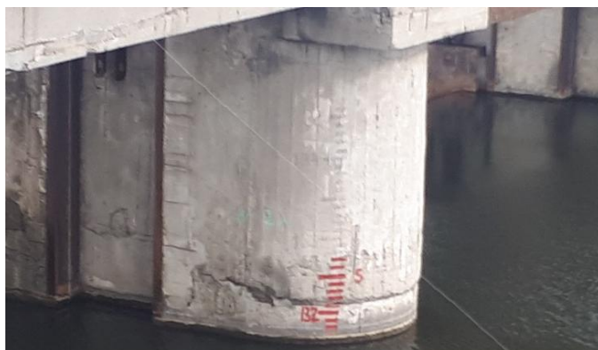
Рисунок 3 – Разметка на быке Амангельдинского водохранилища для определения уровня воды
