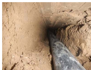
Труба (диаметром 50 mm), установленная в полость
