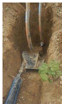
Укладка дренажной трубы начинается с ямы (Труба большого диаметра – направляющая труда)
