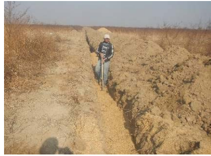
Установка гидрофобного материала (Рисовая шелуха)
