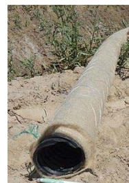
Поперечная дрена, которая будет установлена
