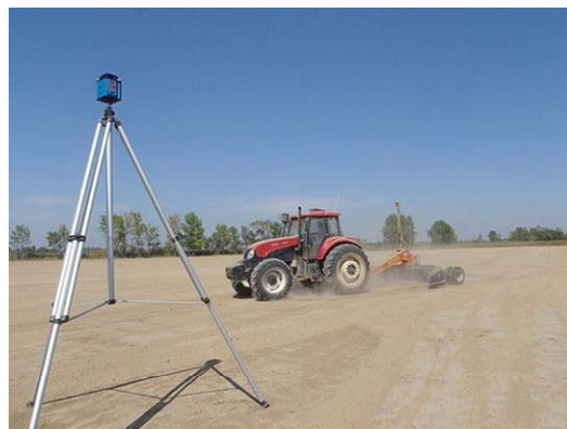
Рис. 2.1.13 Лазерная планировка
