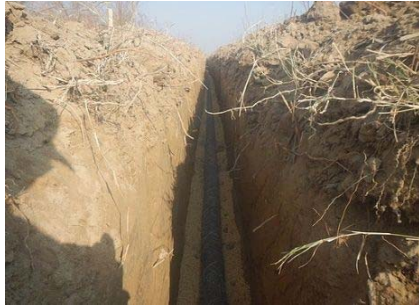
Поперечная дрена в мелкой закрытом дренаже
