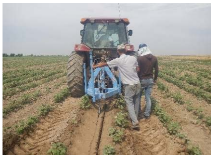
Строительство вспомогательных дрен (кротовых дрен)
