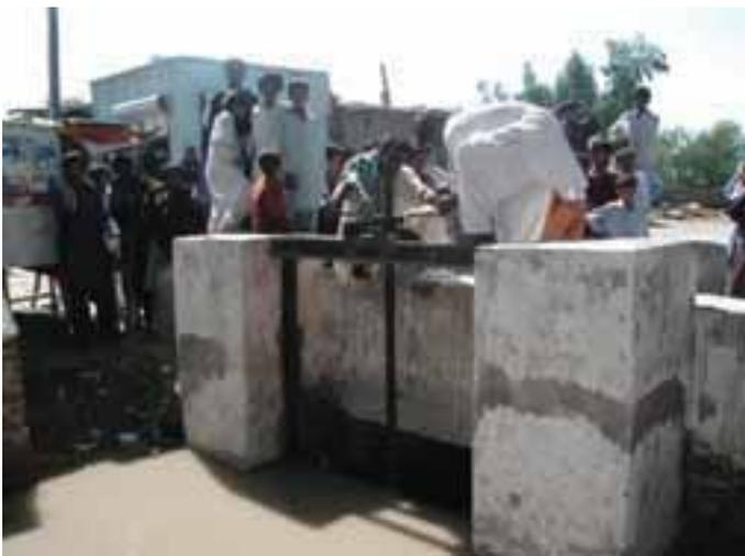
Фото 13 Оборудованное затвором сооружение, которое крайне сложно эксплуатировать – требуется два оператора, чтобы произвести настройку затвора - Синдх, Пакистан
