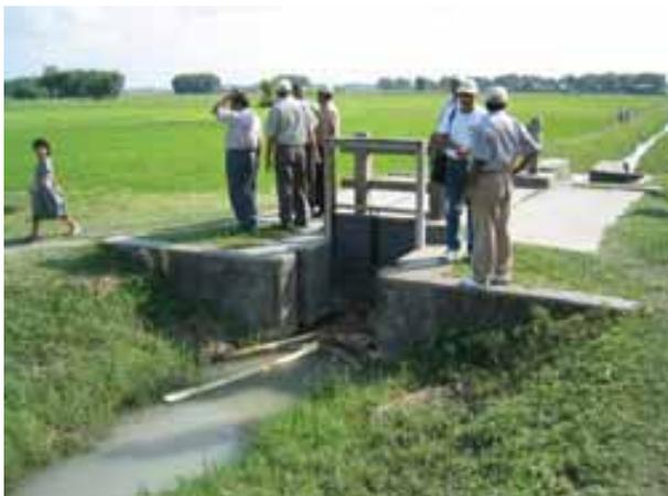
**Фото 12** Неправильно функционирующий шлюз-регулятор (отсутствие ходового винта) на канале второго порядка, SMIS, Непал.
