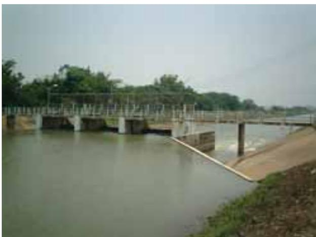
Фото 23 Смешанный поперечный регулятор с центральными затворами под водой и боковыми водосливами, Таиланд. Функционирование регулятора является неправильным – вода должна переливаться поверх гребня.
