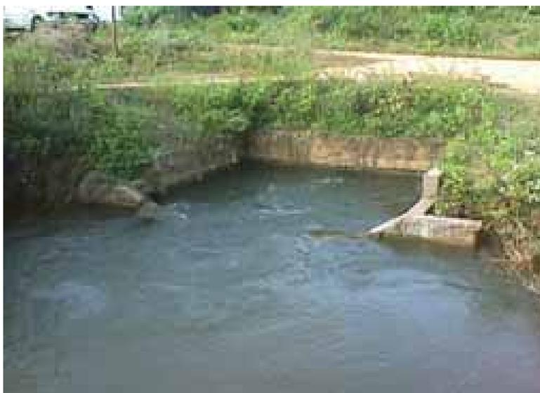
**Фото 16 Водовыпуск в условиях подтопления со стороны нижнего бьефа**
