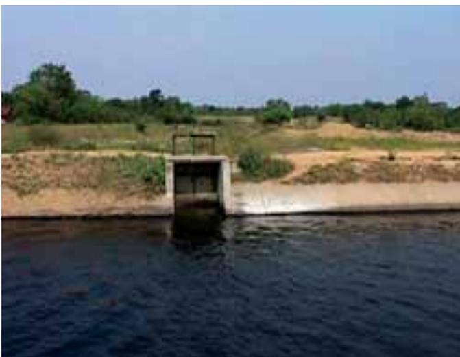
Фото 7 Регулируемое водозаборное сооружение (водовыпуск).
