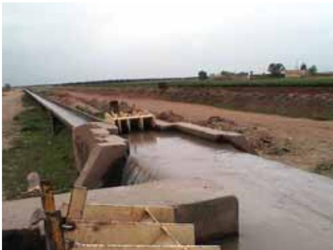
Фото 25 Хвостовой водосброс на канале, оснащенном водоотводами (успокоителями), Тадла, Марокко.
