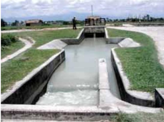
**Фото 18** Нарушение работы пропорционального вододелителя (Непал) с различными условиями в нижнем бьефе: свободное движение воды (главная ветка слева) и движение воды в условиях подпора (маленькая ветка справа). Функциональная способность этого сооружения пропорционально делить сток находится под угрозой.
