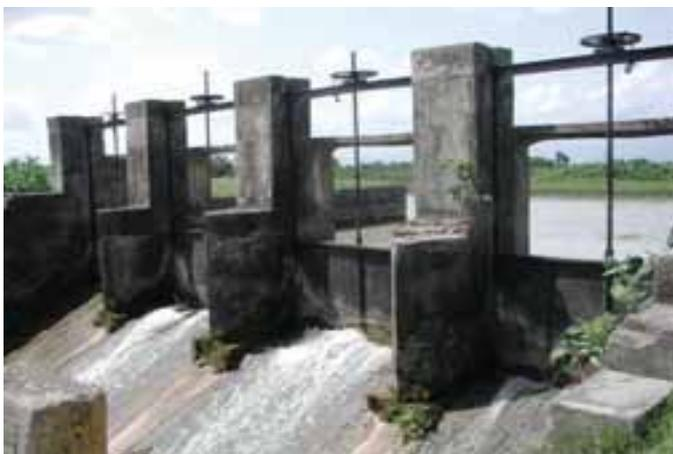
Фото 3 Сооружение со скользящими плоскими затворами (водосброс), SMIS, Непал.
