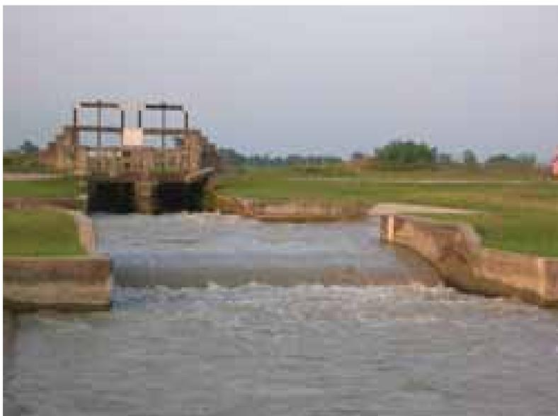
Фото 28 Голова канала второго порядка, оснащенная измерительным устройством (водомером) с очень низкой точностью (Непал).
