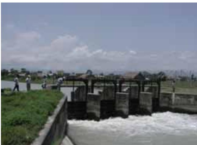
Фото 2 Поперечные регуляторы со скользящими плоскими затворами, SMIS, Непал
