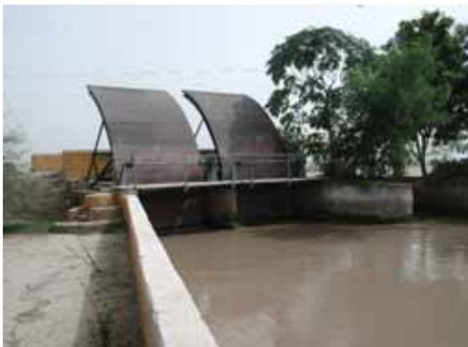
**Фото 11** Неправильно работающий шлюз-регулятор на магистральном канале в провинции Синдх, Пакистан – сегментные затворы полностью блокируются в открытом состоянии, поскольку они не могут закрыться из-за проблем при проектировании.
