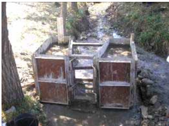
а) на месте при помощи переносной опалубки
