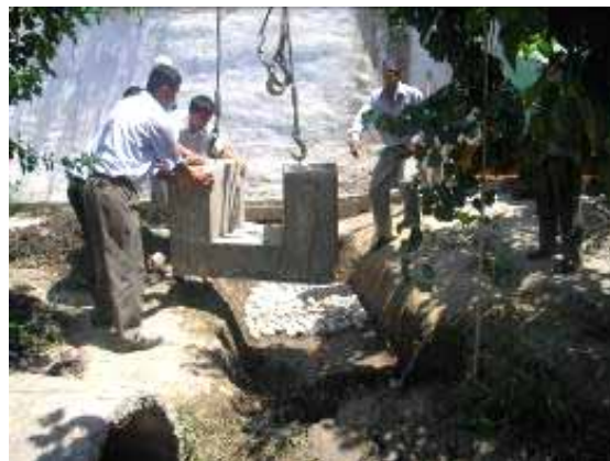
б) монтаж лотка ВЛС заводского изготовления
