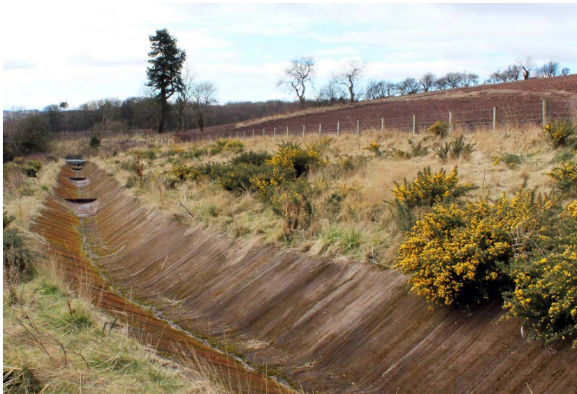
Рисунок 4 – Внешний вид канала через пять лет после установки бетонного полотна Concrete Canvas [6]
