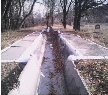
Рисунок 1 – Водомерное сооружение типа “фиксированное русло” на канале Белек-1, р. Ала-Арча
