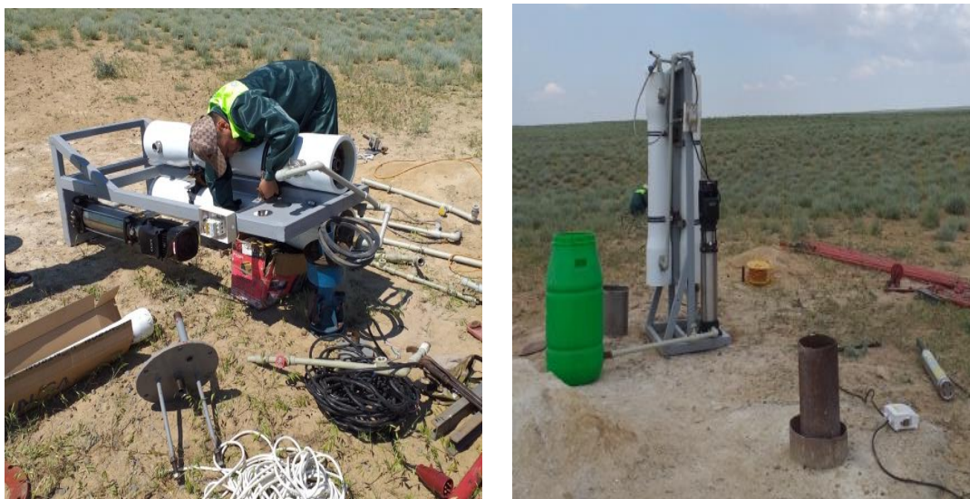
Рисунок 3 – Установка обратноосмотического обессоливания минерализованных вод наземного расположения
