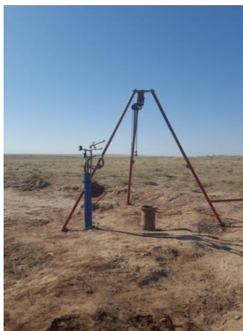
Рисунок 2 – Сборка грузоподъемного приспособления (треноги) для монтажа устройства с насосом в скважину и монтаж устройства с насосом в скважину
