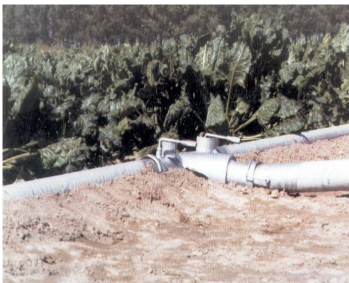
Рисунок 1- Использование дискретной технологии полива по бороздам на посевах сахарной свеклы на опытно-производственном участке Шенгельдинского массива орошения 1997-1999гг.
