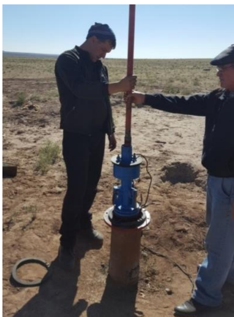
Рисунок 2 – Сборка грузоподъемного приспособления (треноги) для монтажа устройства с насосом в скважину и монтаж устройства с насосом в скважину
