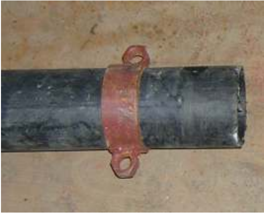
Рис. 2 Установка хомута на трубе
