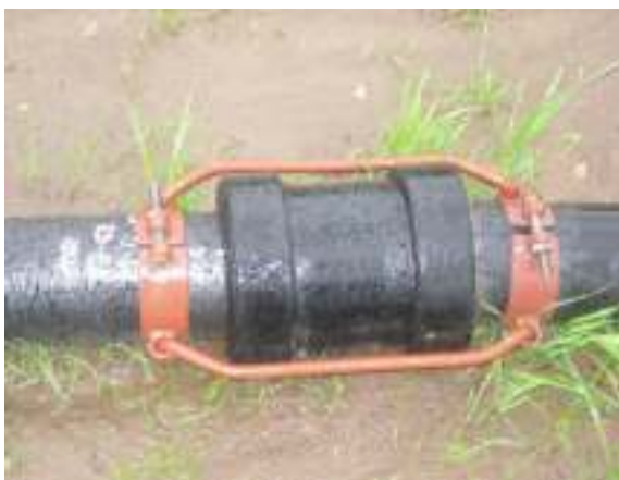
Рис. 3. Соединение труб в муфте
