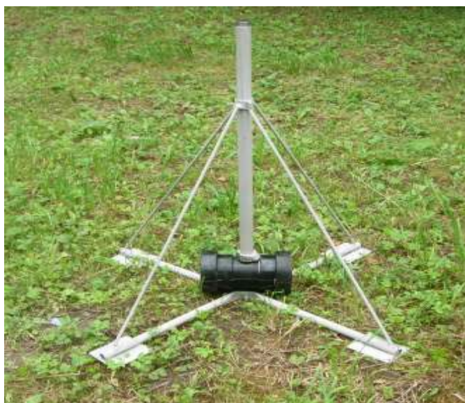
Рис. 6. Установка стояка в муфте
