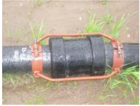
Рис. 3 Соединение труб в муфте
