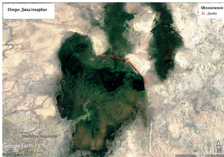
Рис. 1. Дамба, построенная в северо-восточной части оз. Джылтырбас. Fig. 1. The dyke constructed in the north-eastern part of the Lake Dzhylytyrbas.
