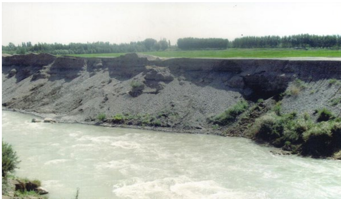
Рисунок 11. ПК 570+80 часть Шахрихансайского канала.
