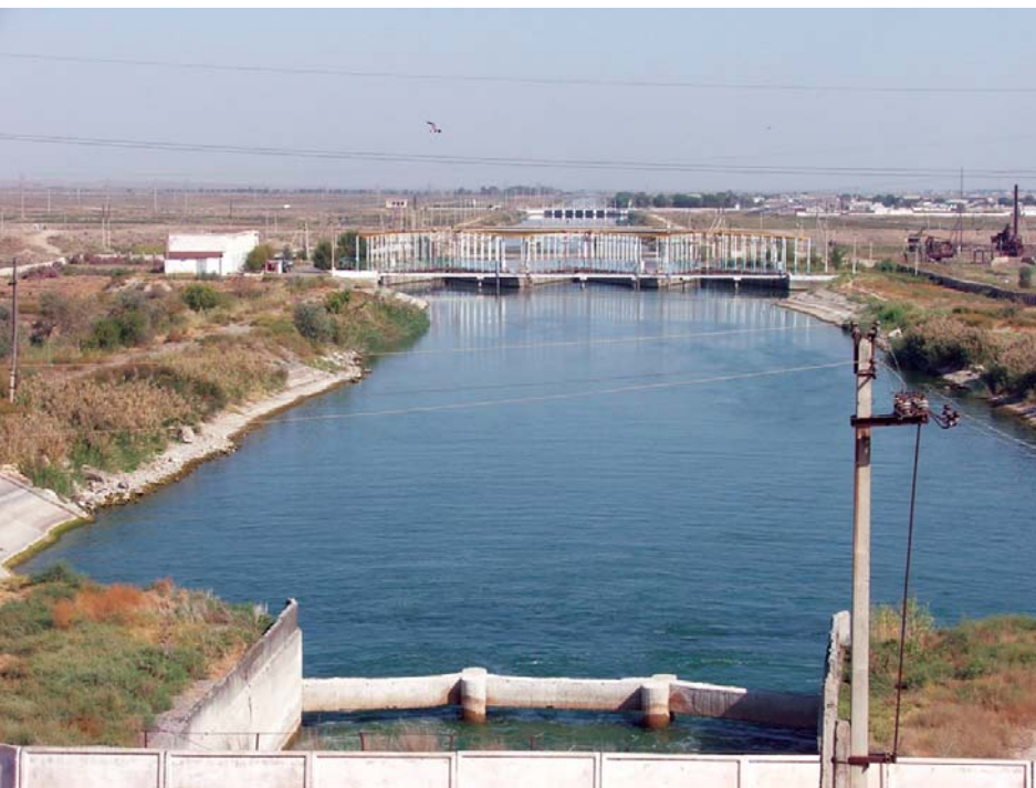
Кызылкумский магистральный канал
