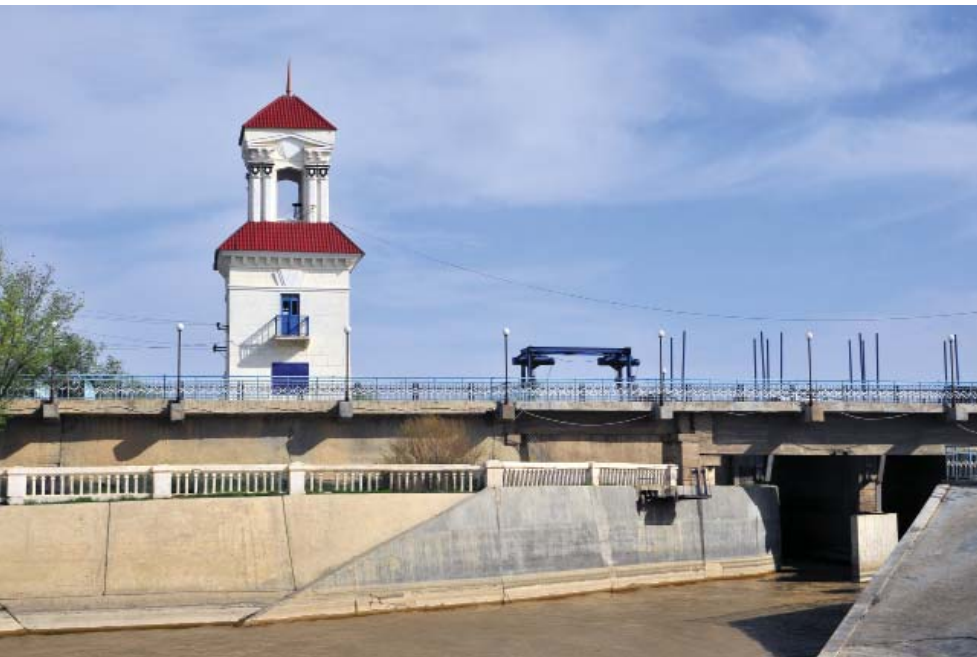
Кызылординское гидротехническое сооружение
