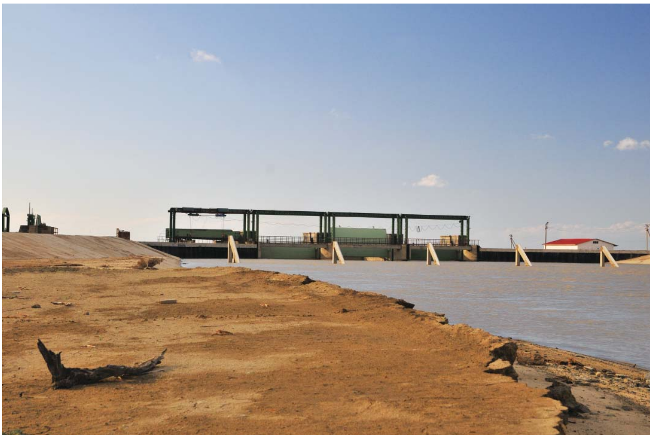
Гидротехническое сооружение на р. Сырдарья
