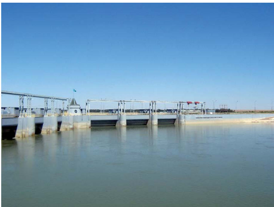
Коксарайское гидротехническое сооружение
