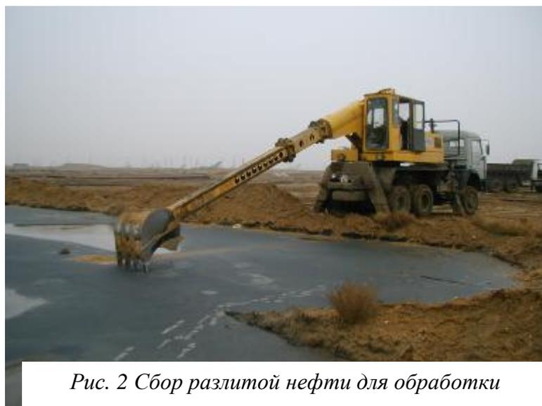
*Рис. 2 Сбор разлитой нефти для обработки*
