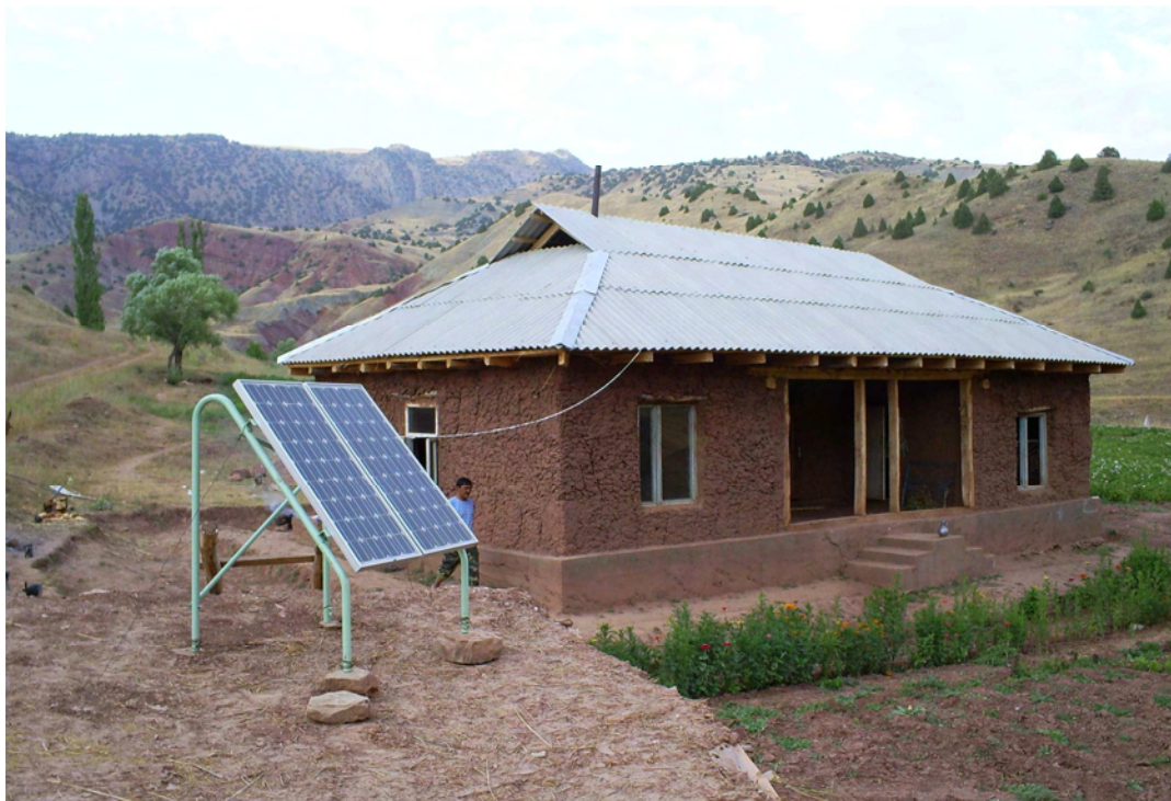
Кашкадарьинская область. Бытовая фотоэлектрическая станция в Гиссарском заповеднике
