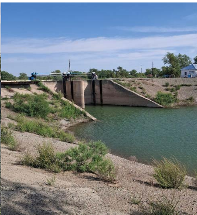
Головное сооружение канала Маринкинузьяк, пропускная способность 36 м 3 /с.
