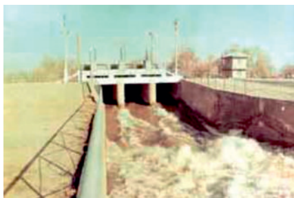
Подпитывающее сооружение на 42 км канала Шаватской ветки
