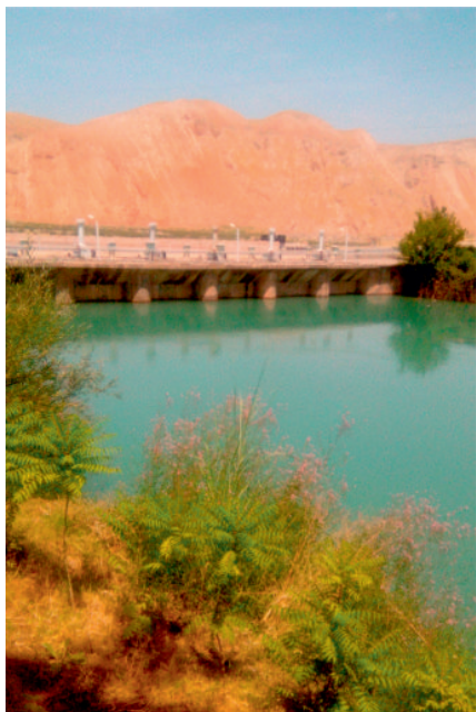
Нижний бьеф Бешкентского гидроузла
