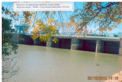
Головное сооружение «Клычниязбай»
