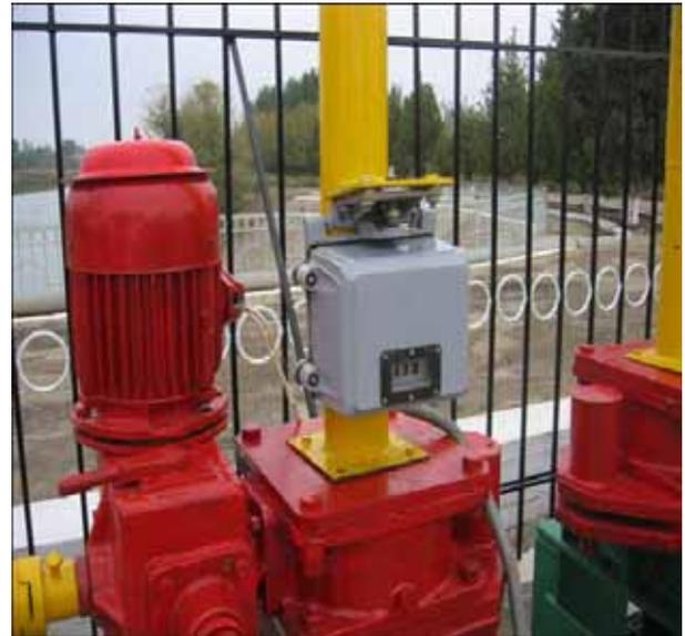
**Рис. 6. Установка ДПЗ на винт затвора**
