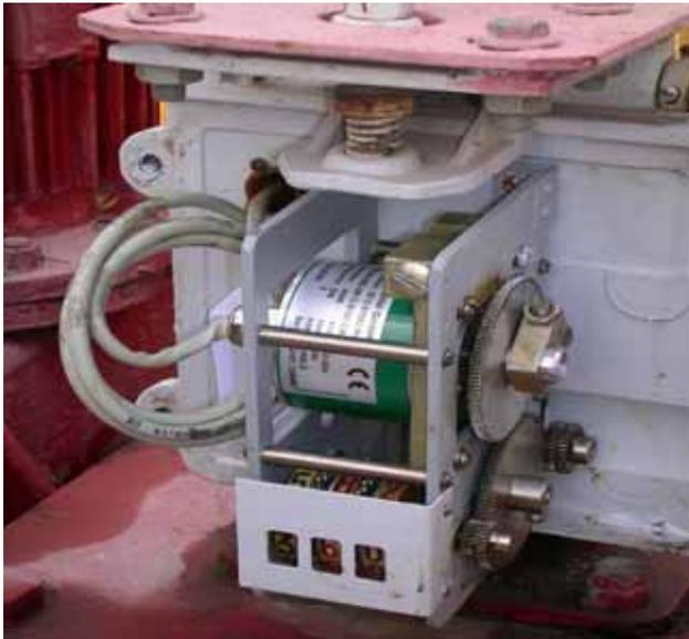
**Рис. 5. Датчик положения затвора (ДПЗ)**
