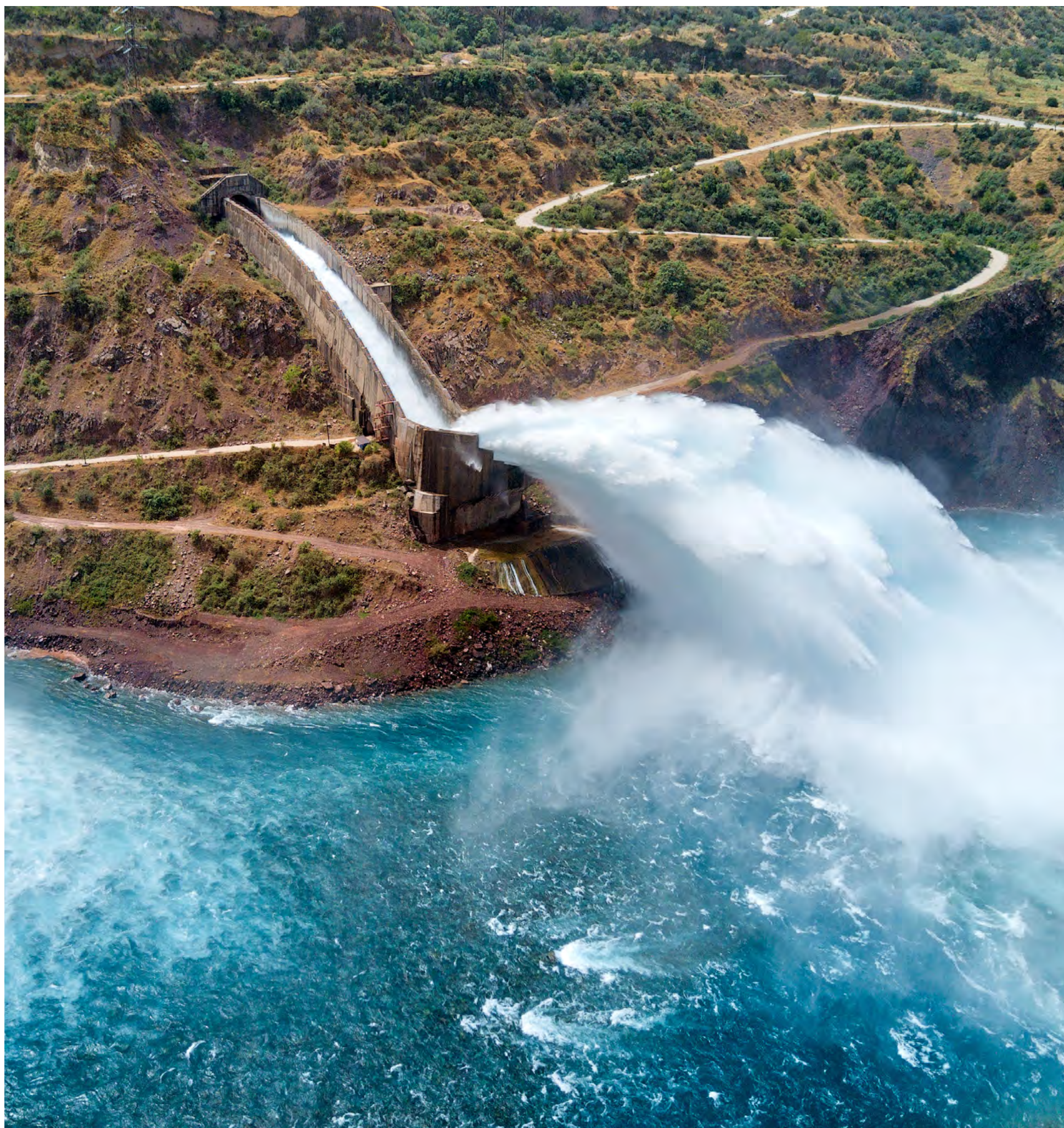
Водосброс Нурекской плотины, август 2018 года
