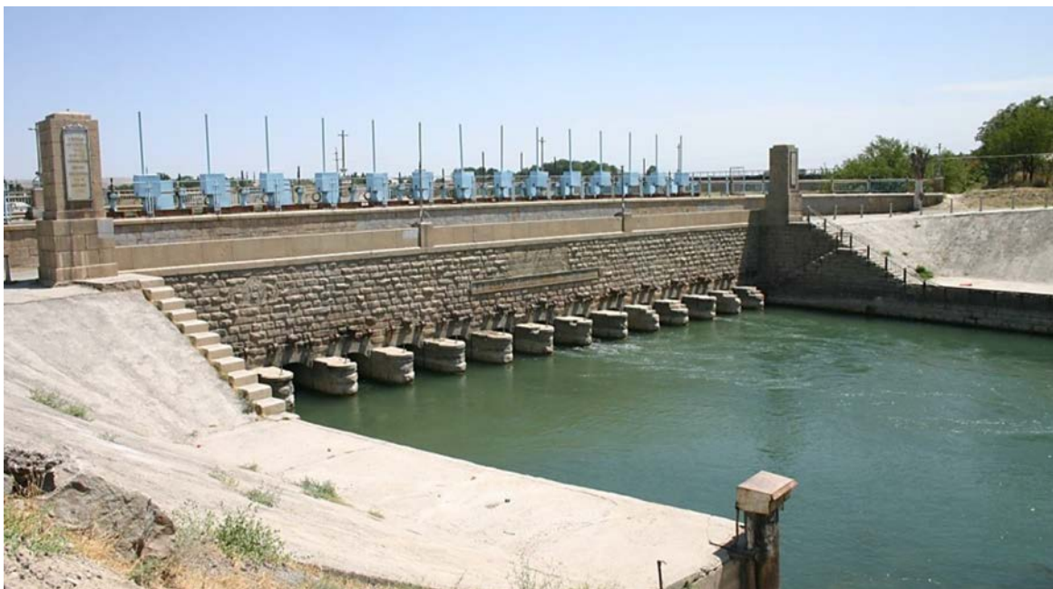
Старое головное сооружение канала Дуслик
