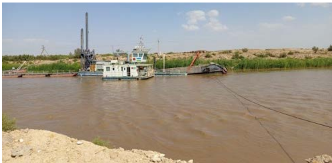
Земснаряд на очистке русла АБМК
