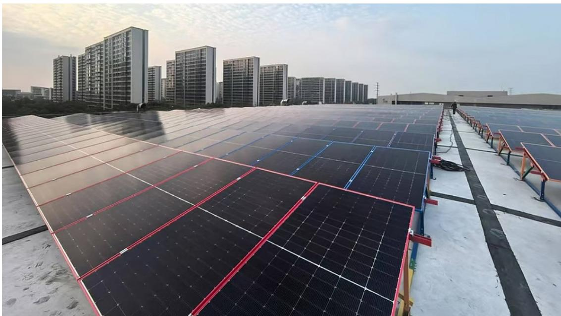
*Солнечные модули с рамами из полиуретанового композита.*
