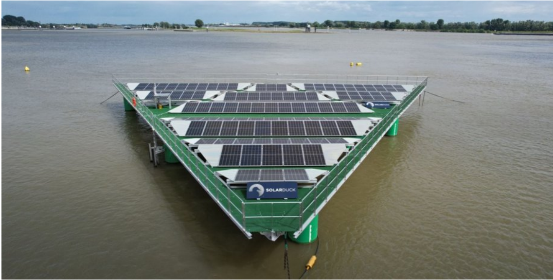
Солнечная электростанция SolarDuck
