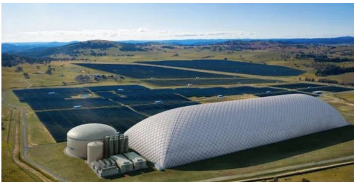
Энергетический купол от Energy Dome и ENGIE
