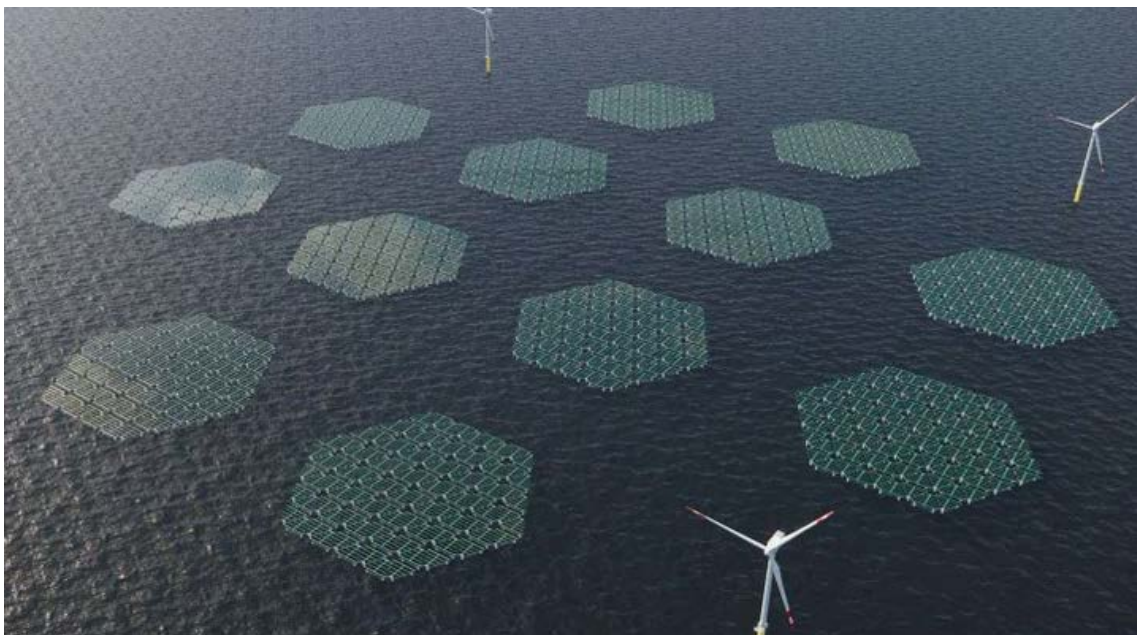
Водные солнечные электростанции SolarDuck
