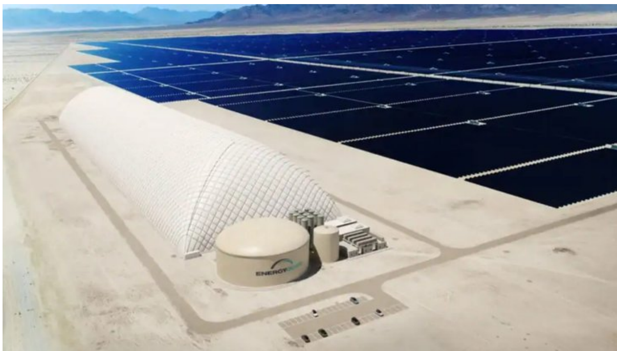
Систему Energy Dome разместили рядом с солнечной электростанцией, чтобы эффективно хранить энергию
