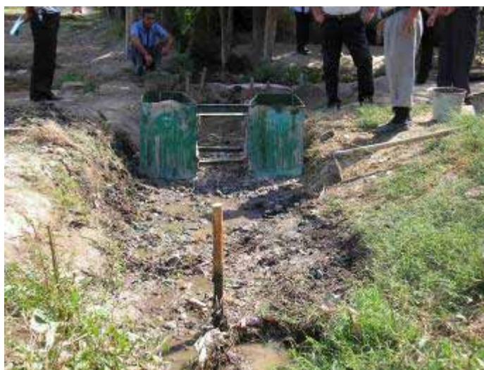
Рис. 13. Установка металлической опалубки для лотка САНИИРИ по оси участка канала.
