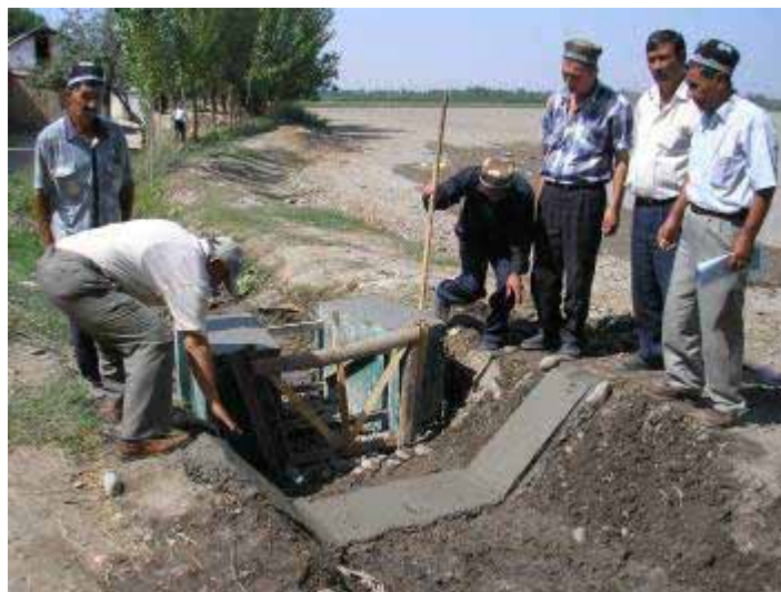
Рис.14. Часть бетонной облицовки подводящего русла гидрометрического поста с лотком САНИИРИ.
