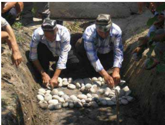
Рис.12. Укладка каменной наброски под основание водомерного устройства.
