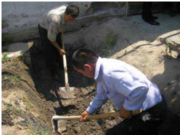
Рис.11. Очистка дна канала от ила и водной растительности.
