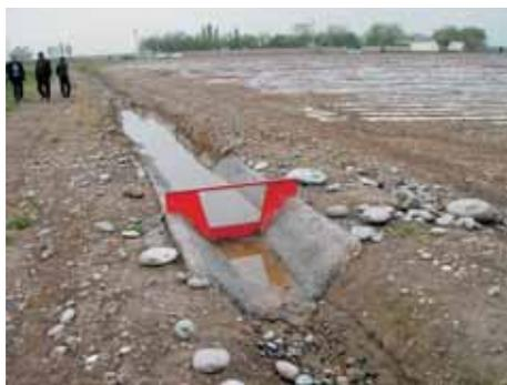
Водомерное устройство на поле,
