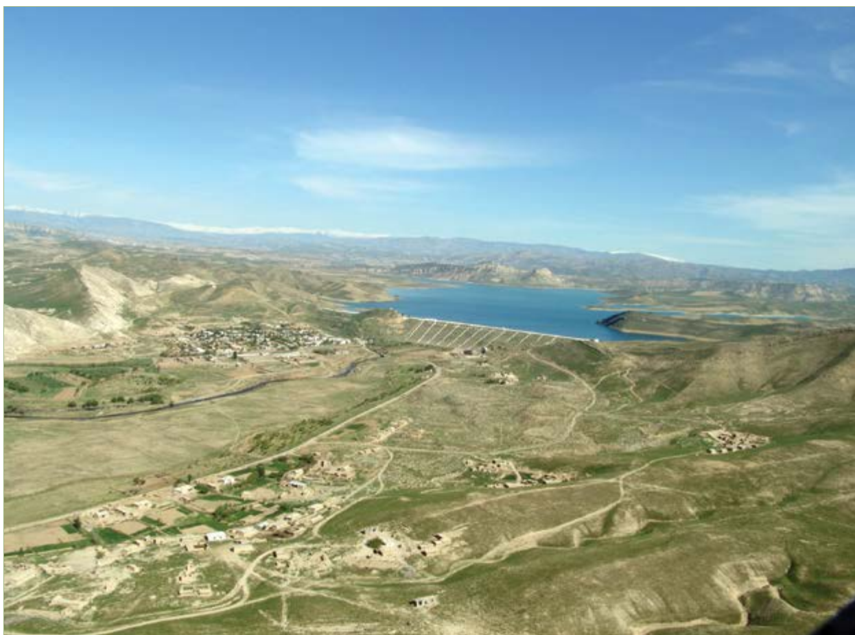
Рис. 5.3. Пачкамарское водохранилище в Узбекистане
