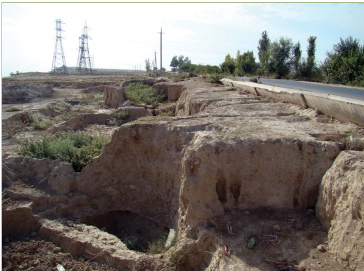
Рис. 5.6. Эрозия лессовой породы в результате утечки воды из оросительного канала (Андижан)
