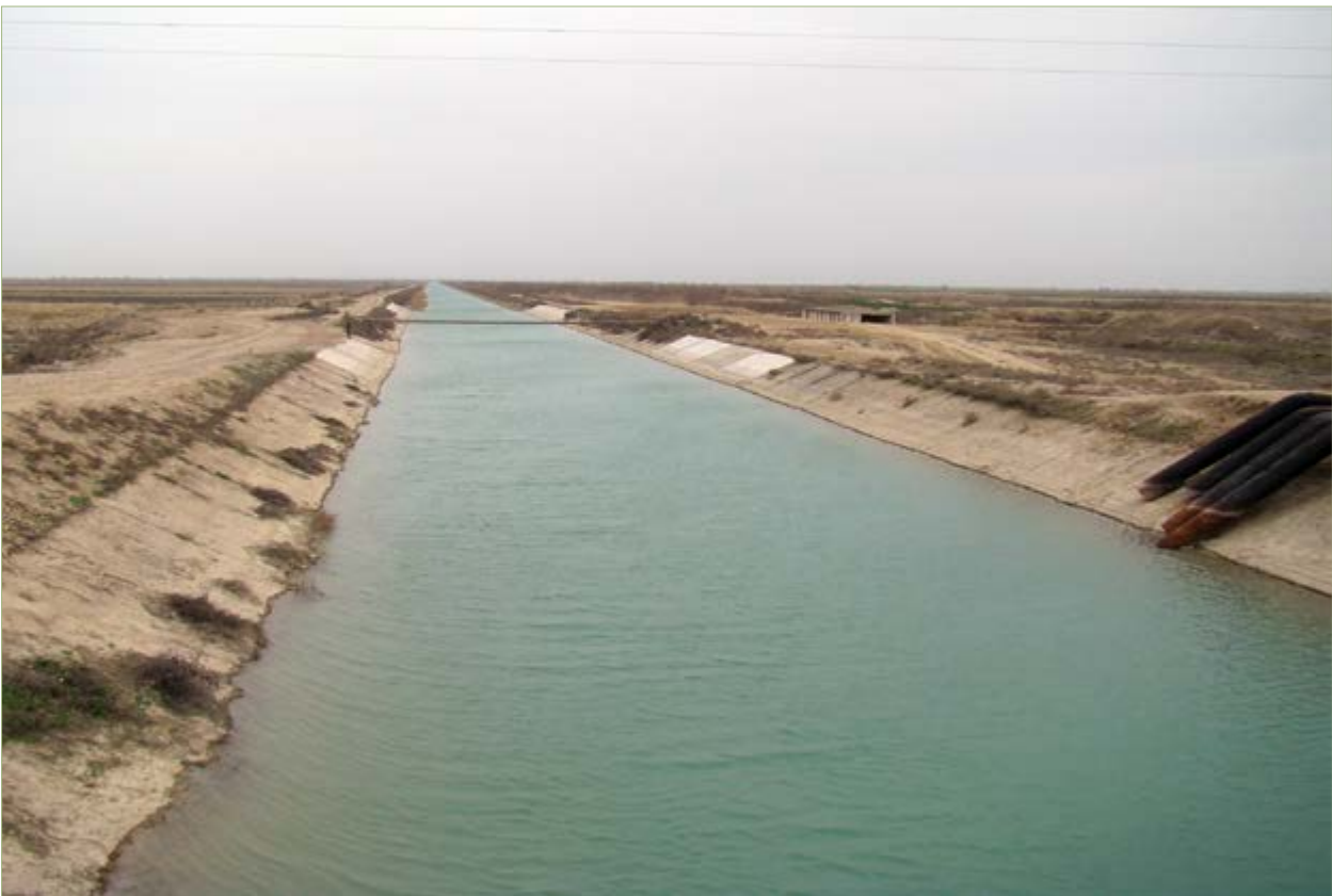
Рис. 5.5. Южно-Голодностепский ирригационный канал с бетонной облицовкой на поверхности пролювиальных лессовых пород
