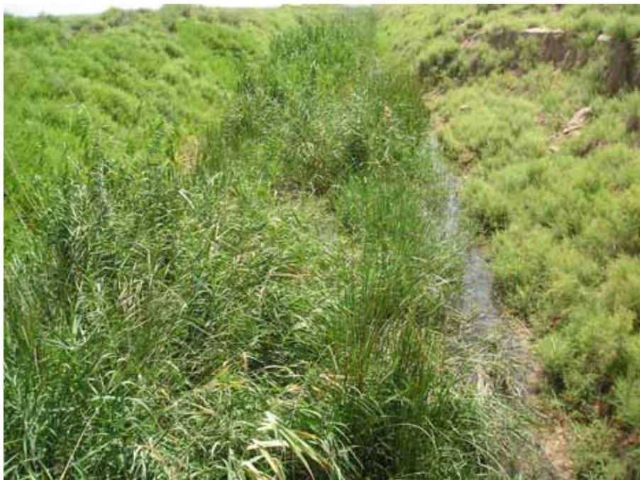
Рис. 1 - Общий вид коллектора с плотно (свыше  $300 \text{ шт/м}^2$ , тростник, рогоз) заросшим дном и откосами.
