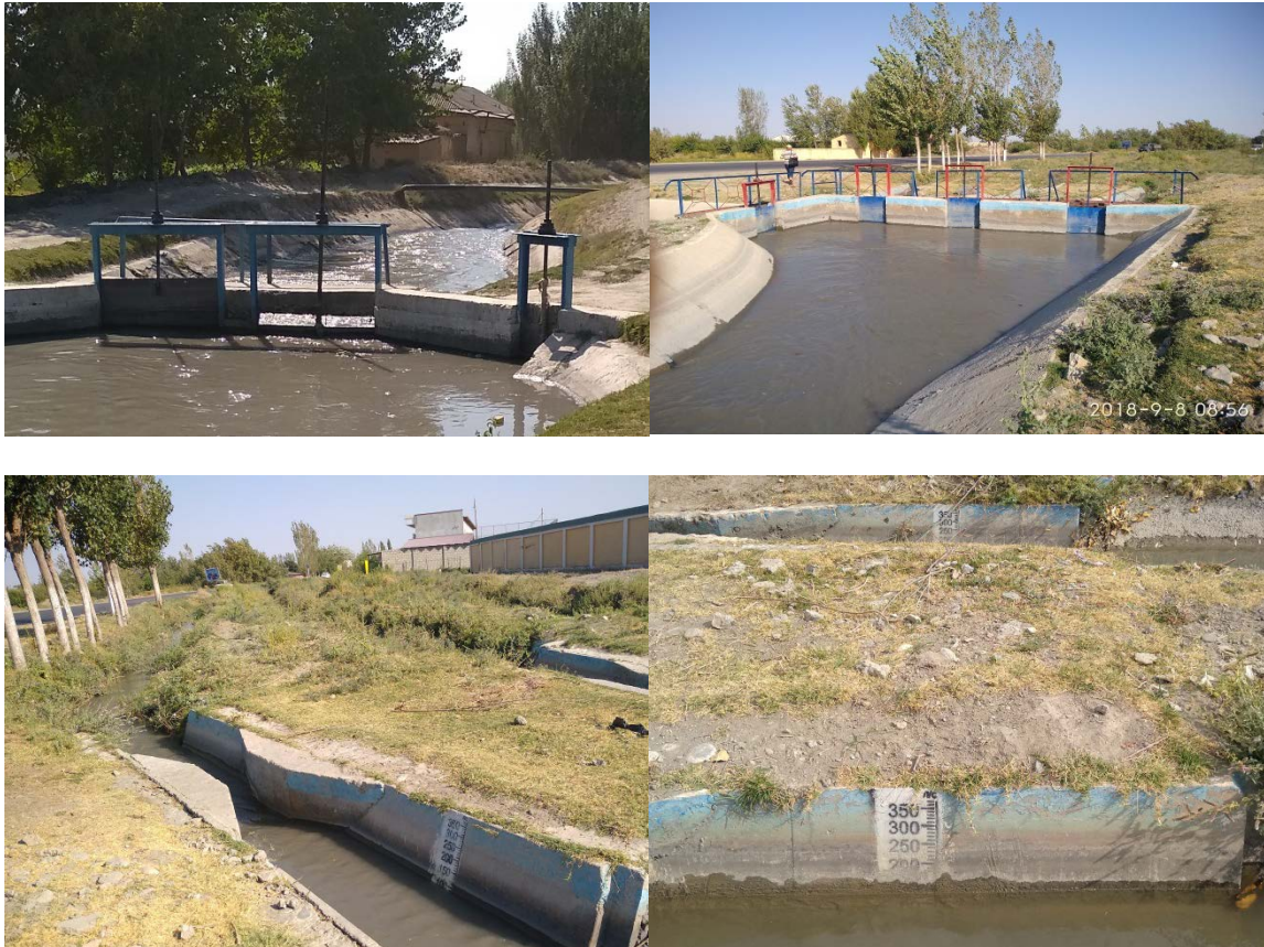
Рис. 1. Регулирующие сооружения и гидропосты в голове отводов в ОВП
