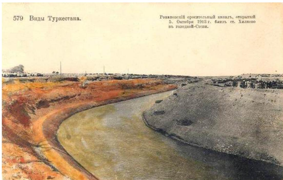
Для недопущения вовлечения наносов в канал оно располагалось в непосредственной близости от реки с забором воды из верхних горизонтов. Место строительства сооружения было выбрано на коренном вогнутом берегу, сложенном из конгломератов. При таком решении отпадала необходимость в строительстве промывного шлюза и сбросного сооружения. Особое внимание уделялось необходимости детальной разработки проектов распределительной сети.
