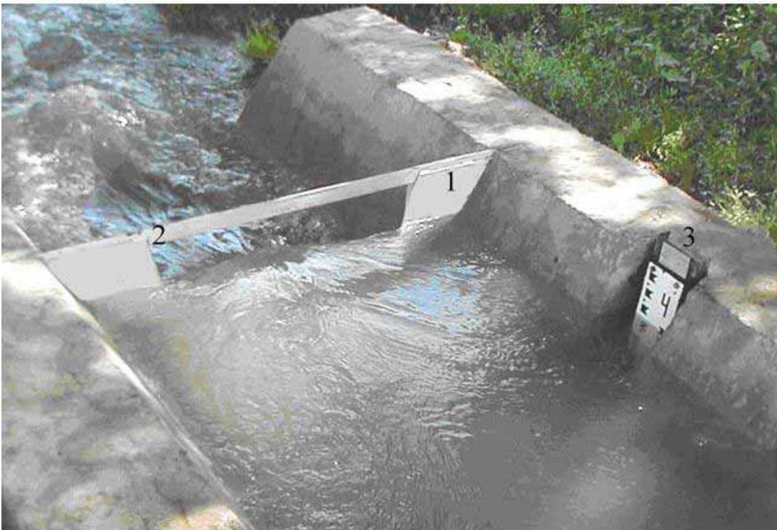
**Рис. 4. Трапецеидальный водослив**
