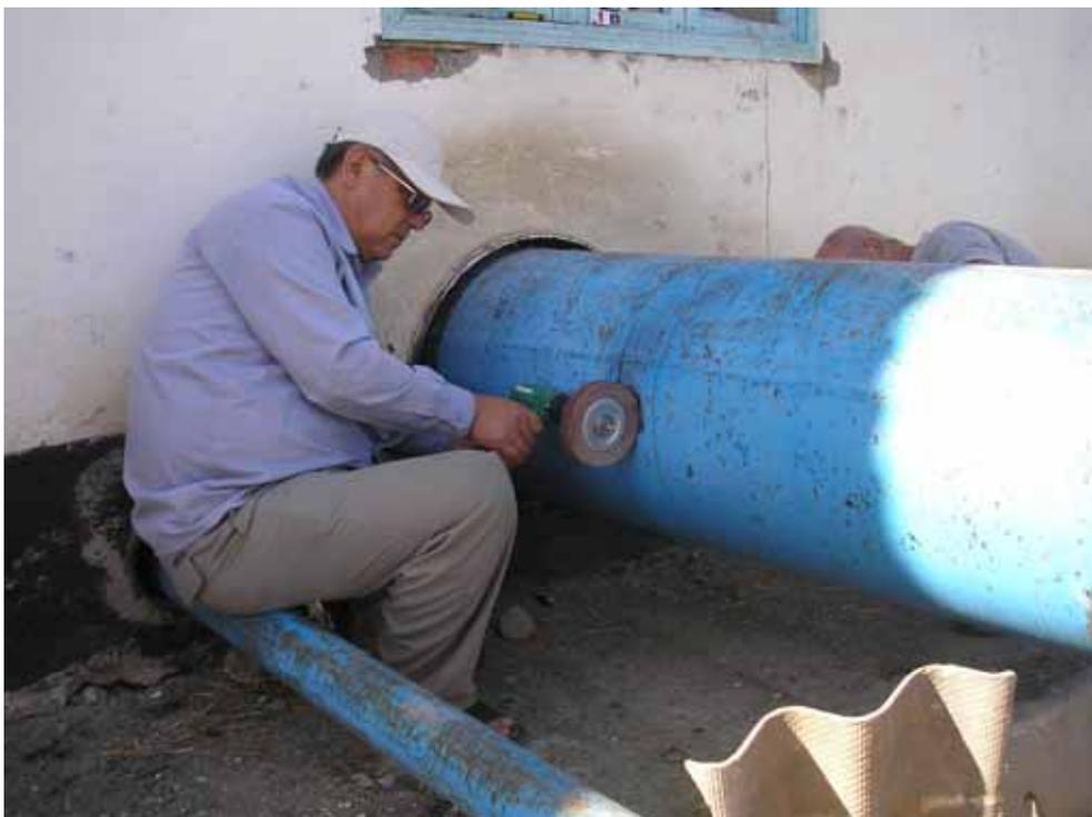
**Очистка места установки накладных ультразвуковых датчиков**
