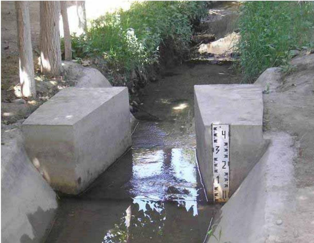
**Рис. 5. Водомерный лоток САНИИРИ**
