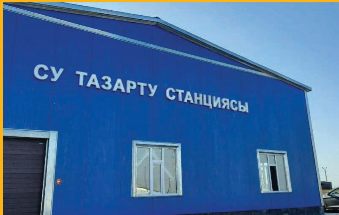
Станция очистки воды Майского группового водопровода
