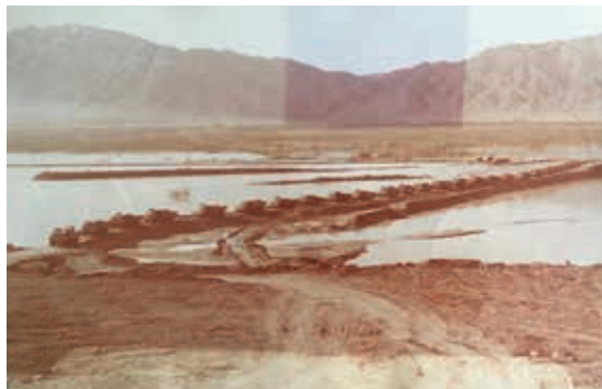
Строительство Бартогайского водохранилища – момент перекрытия воды реки Шелек.
