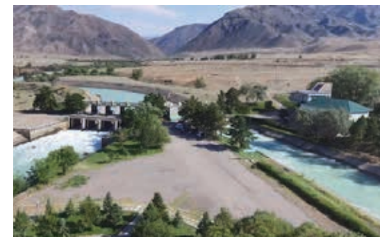
Головное сооружение БАК
