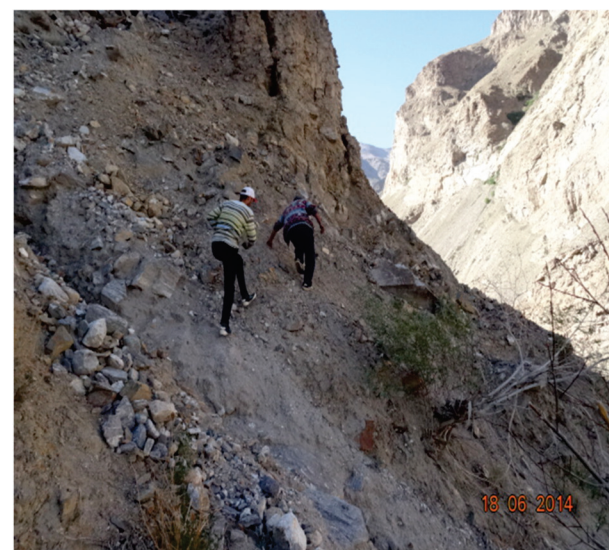
Рис.10. (а; б) Разрушенная часть канала по саю Оджатга в результате оползневых явлений. Автор фотографии Гоибназаров А.
