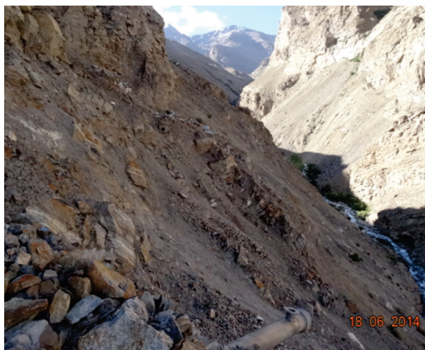
Рис. 9 (а; б) Оползнеопасный склон Занудж. Разрушенная часть канала в результате активизации оползня. Автор фотографии Гоибназаров А.
