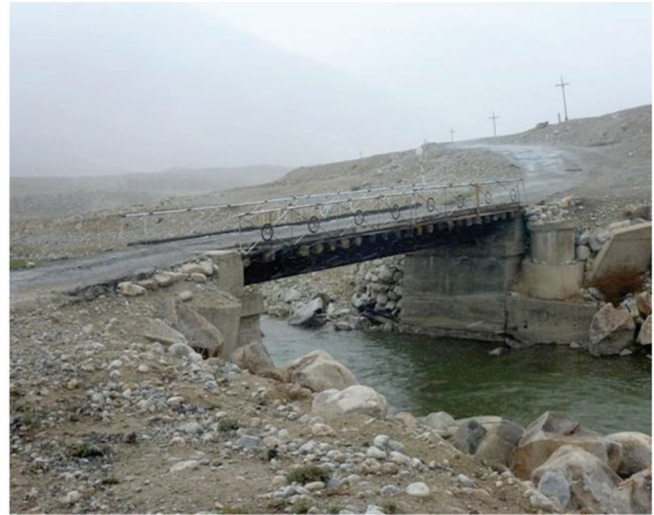
Рис. 8. Автомобильный мост через р. Тогузбулок (кишлак Джелонди)
