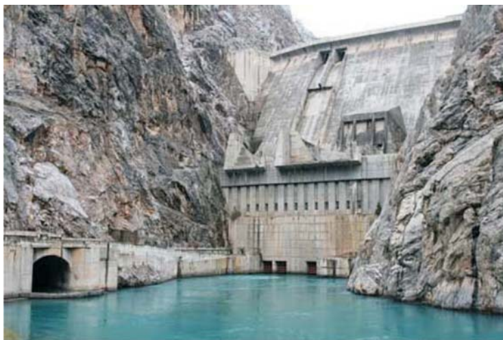
Токтогульская ГЭС Фото: ОАО "Электрические станции"
