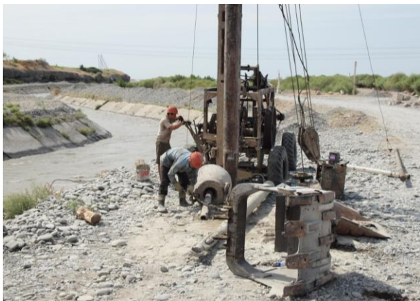
Скважина для наблюдения за уровнем подземных вод на головном сооружении Раватходжа
