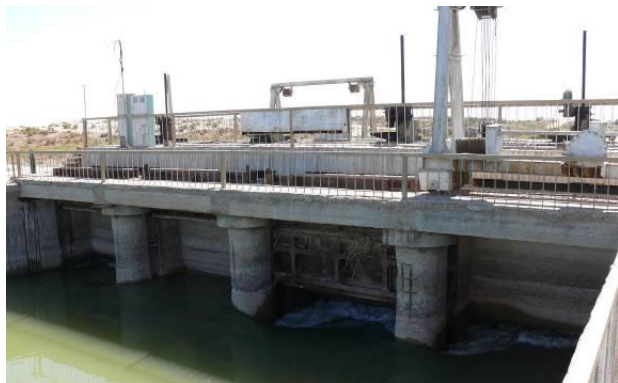
Регулятор Ханховузского канала нуждается в ремонте
