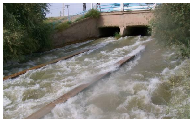
Ханховузский ирригационный канал
