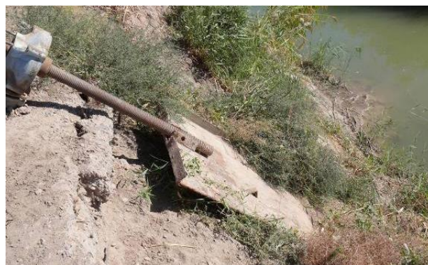
Разрушающаяся часть ирригационного канала
