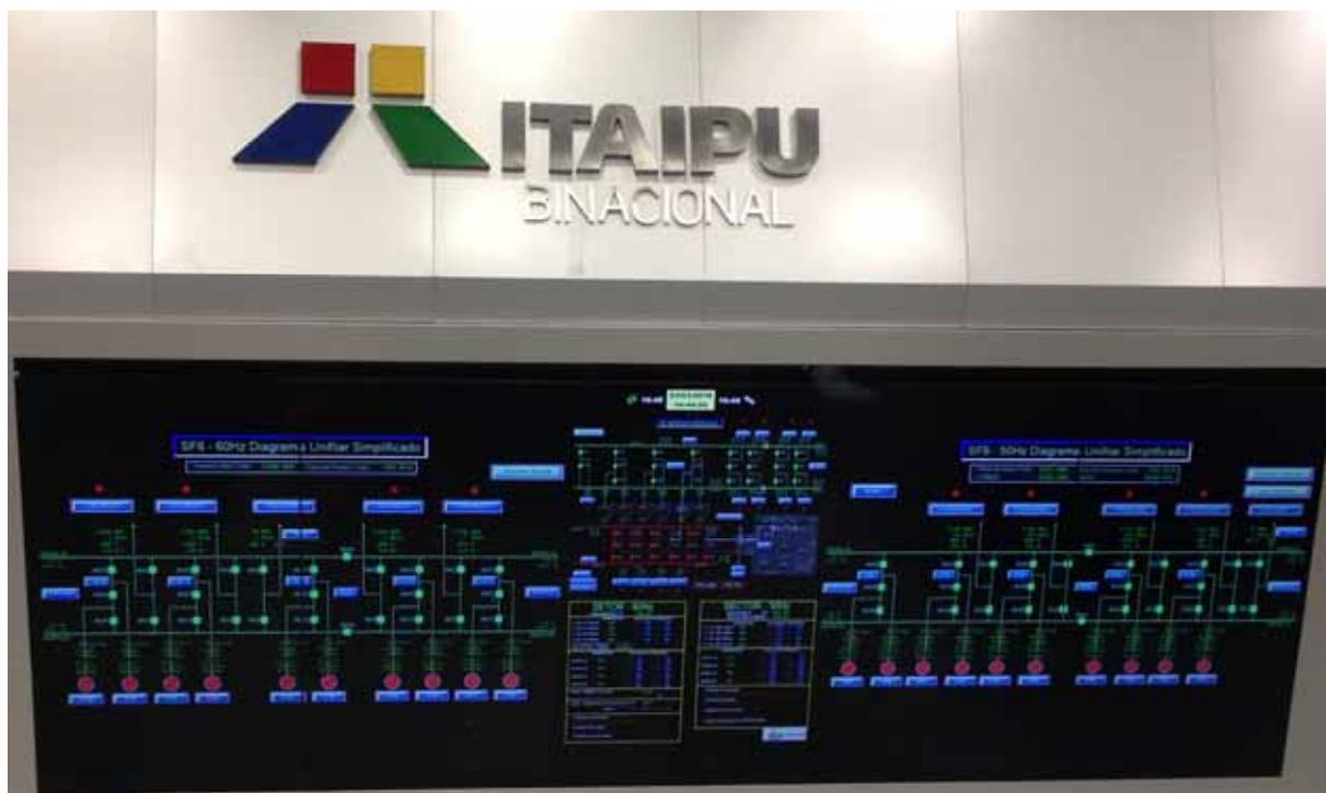
В момент посещения ГЭС работала на полную мощность: 10 турбин вырабатывали электроэнергию для Бразилии в 60 Гц (слева), 10 турбин для Парагвая в 50 Гц (справа).
