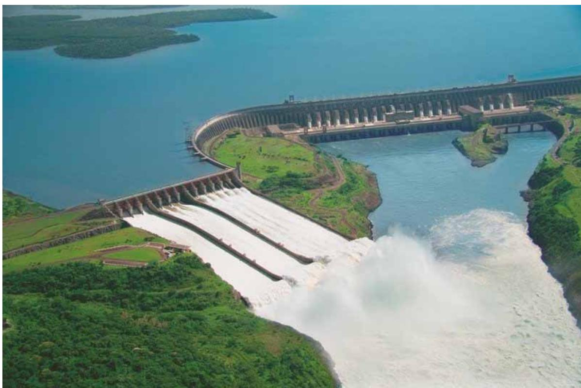
Комбинированная плотина общей длиной 7235 м, шириной 400 м и высотой 196 м и бетонный водосброс с максимальным потоком в 62 200 м<sup>3</sup>/с. Фото: 2017 Masahub.
