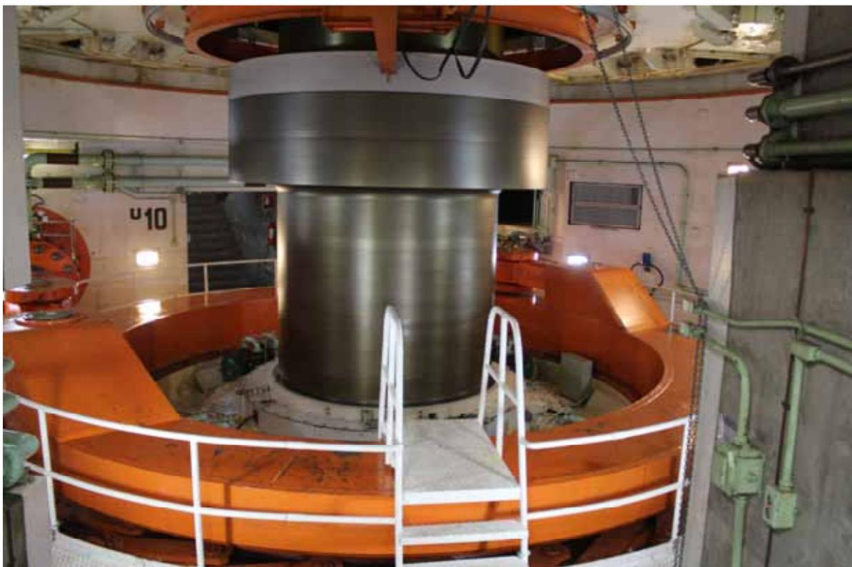
Силовое оборудование станции состоит из 20 гидроагрегатов мощностью по 700 МВт.
