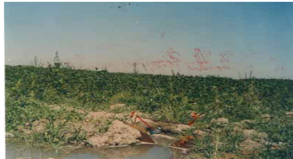
Фото 4. Армирование оголовка поливной борозды посредством полимерной бутылки из под минеральной воды 1 - полимерная бутылка; 2 – водослив Томсона
