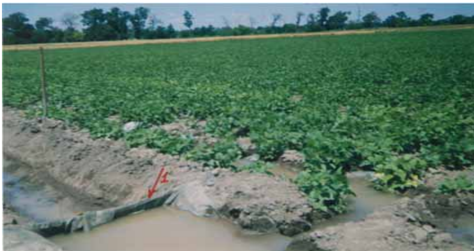
Фото 7. Гибкий перегораживающий подпорный щит – регулятор расхода воды
