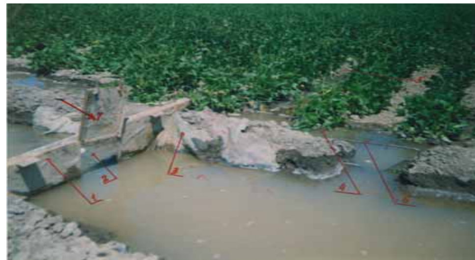
Фото 6. Жесткий, с регулирующим окном, перегораживающий подпорный щит
