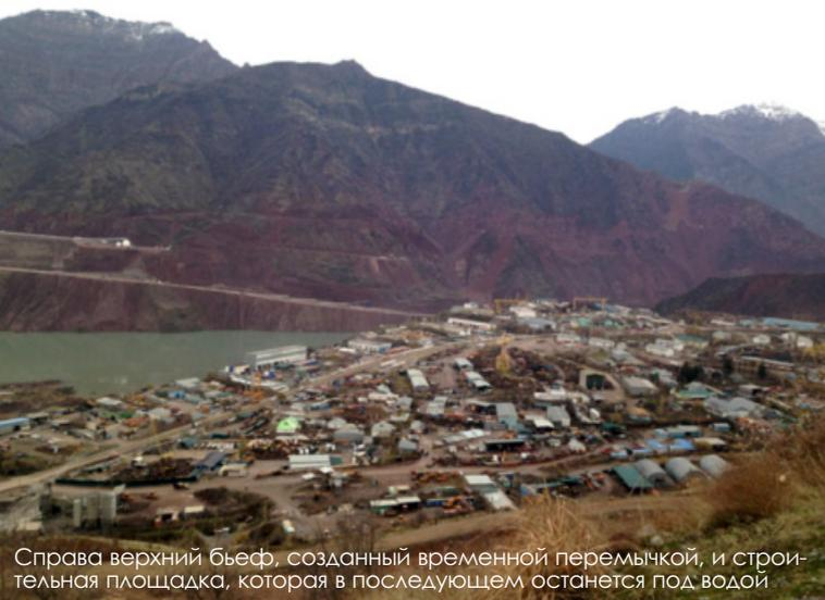
Справа верхний бьеф, созданный временной перемычкой, и строительная площадка, которая в последующем останется под водой
