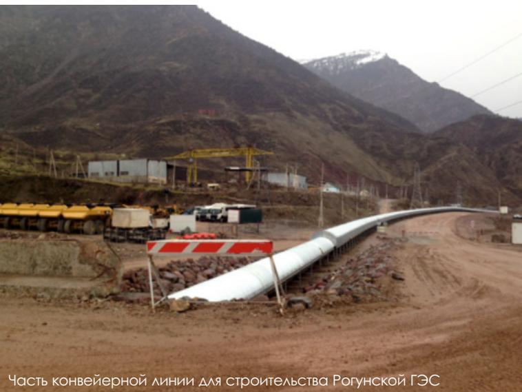
Часть конвейерной линии для строительства Рогунской ГЭС
